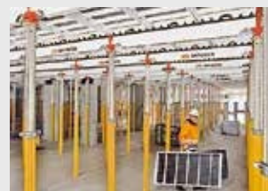
Encofrados para losas
