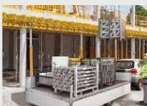
Componentes y accesorios para la obra
