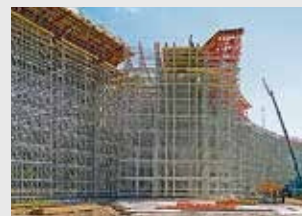
Cimbras y torres de carga
