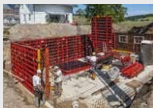
Encofrados para muros
