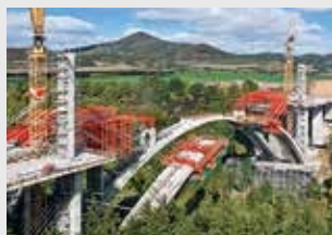
Encofrados para puentes
