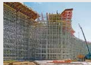
Cimbras y torres de carga
