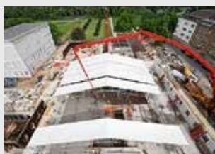
Andamios de protección
