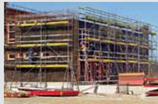
Andamios de trabajo para la construcción
