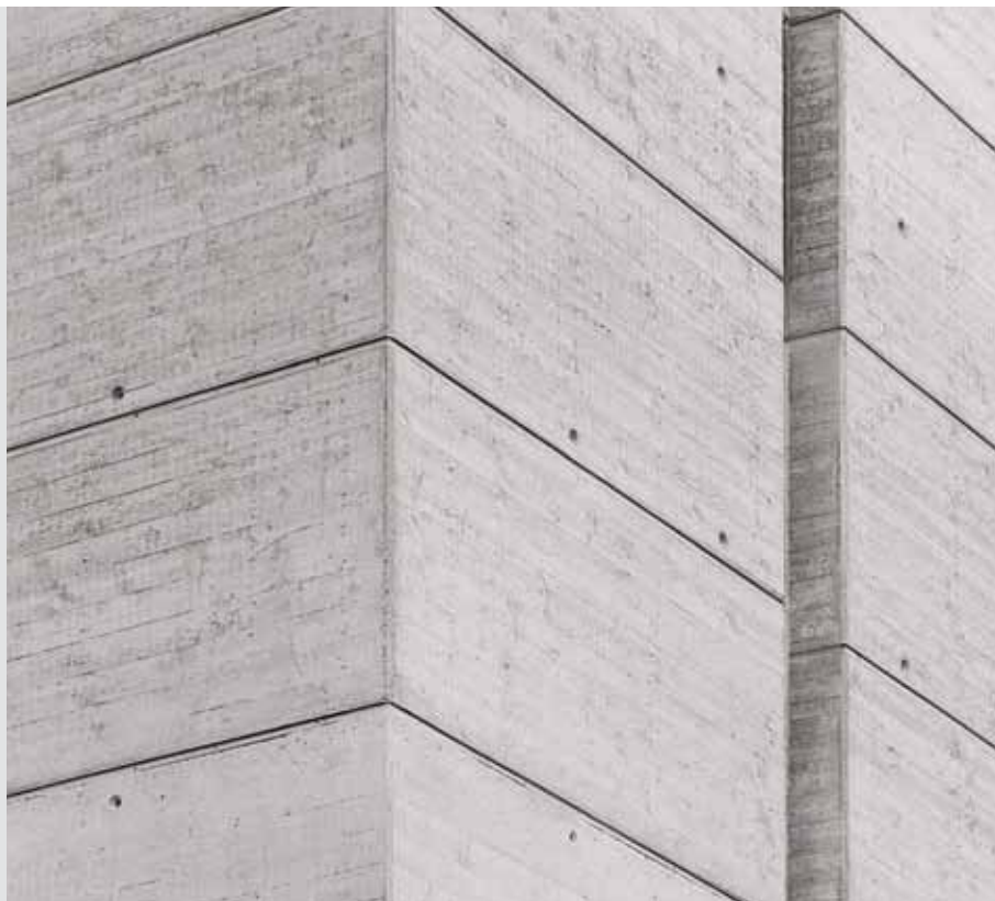
Hormigón visto impecable con textura rugosa de entablado horizontal.
