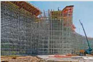
Cimbras y torres de carga
