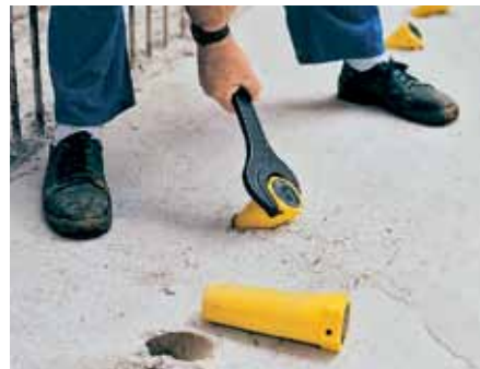
La regleta de posicionamiento se desmonta con la llave de boca nº 70.
