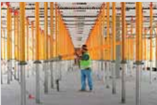
Encofrados para losas
