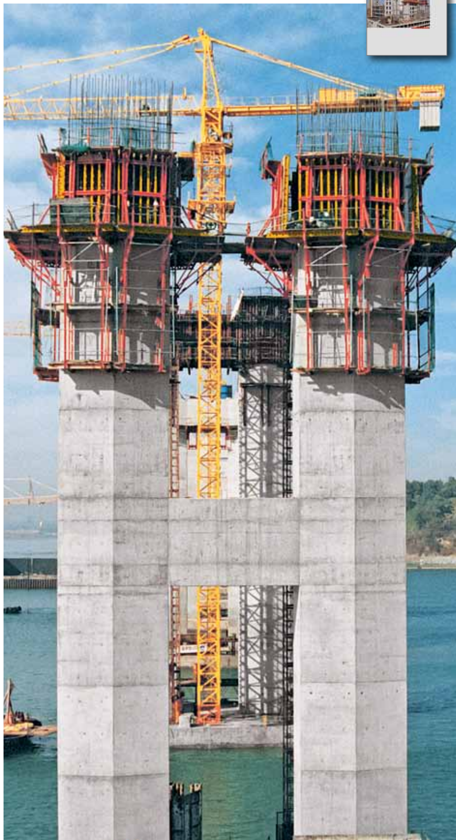
La CB 240 es la consola triangular, para un trabajo seguro, delante y detrás del encofrado.
