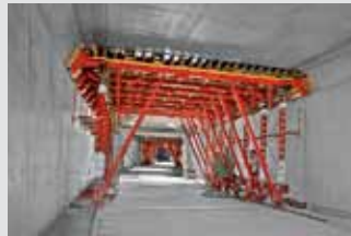
Encofrados para túneles
