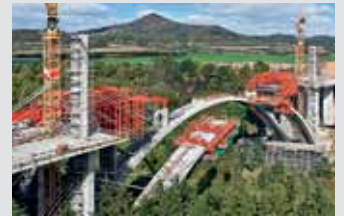
Encofrados para puentes
