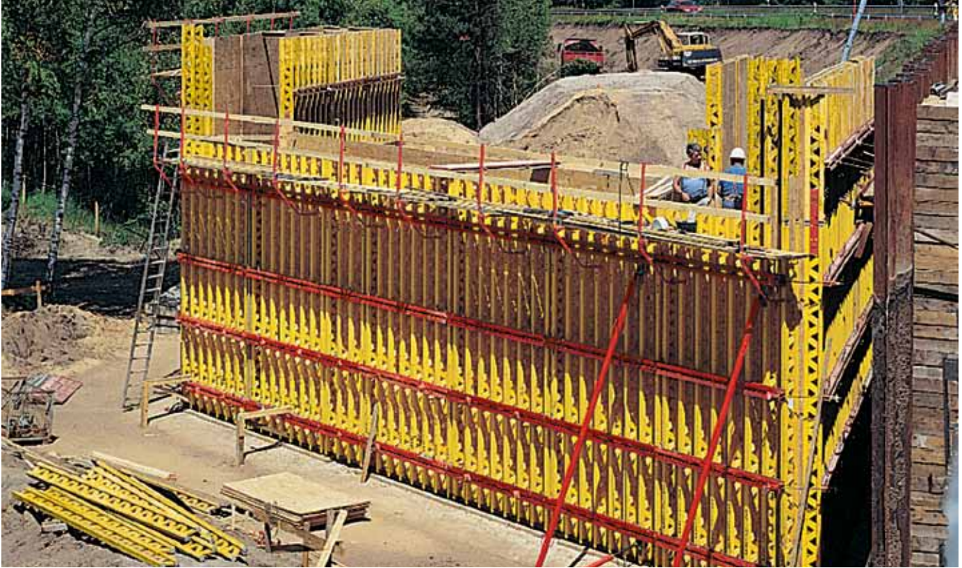
Puente sobre el Danubio, autopista BAB 8, cerca de Leipheim.
