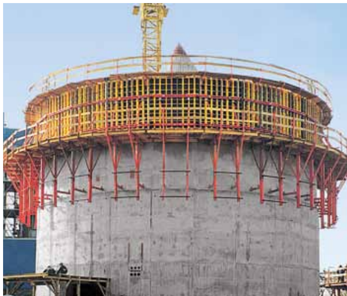
VARIO GT 24 para la construcción de un tanque circular. Con cuñas de madera entre viga y correa se obtiene la forma circular.
