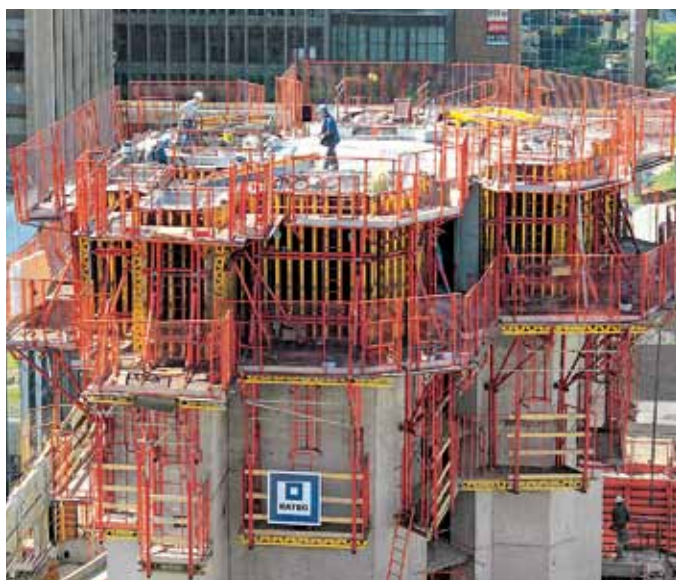
Edificio en París con VARIO GT 24 y consola trepante CB 240.
