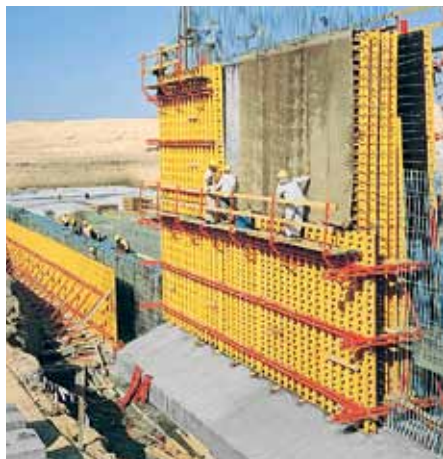
VARIO GT 24 para la construcción de una planta de tratamiento con muros cónicos.
