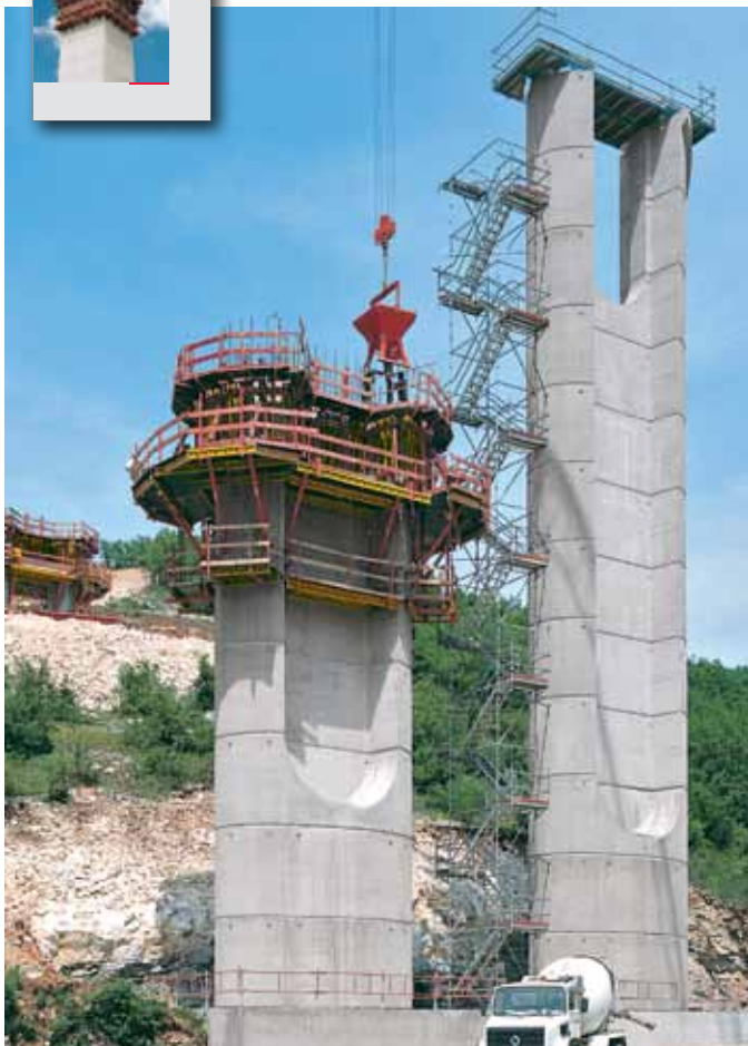
Viaducto de autopista en Francia. Compleja geometría de pila, con acabado extraordinario del hormigón. Encofrado con VARIO GT 24 y consolas trepantes SKS.
