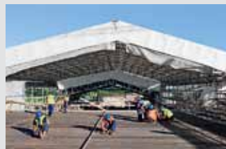
Andamios de protección
