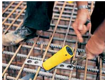
El anclaje se fija fácilmente sobre la armadura, con alambre y pinza.
