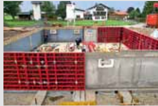
Encofrados para muros
