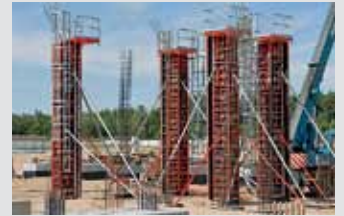
Encofrados para pilares y columnas circulares
