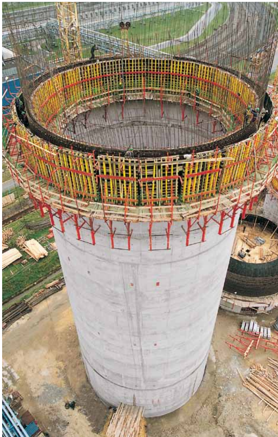
Silo de h = 72 m, \varnothing = 20 m en la central eléctrica de Oppeln, Polonia. Encofrado con VARIO GT 24 circular sobre consola trepante KGF.
