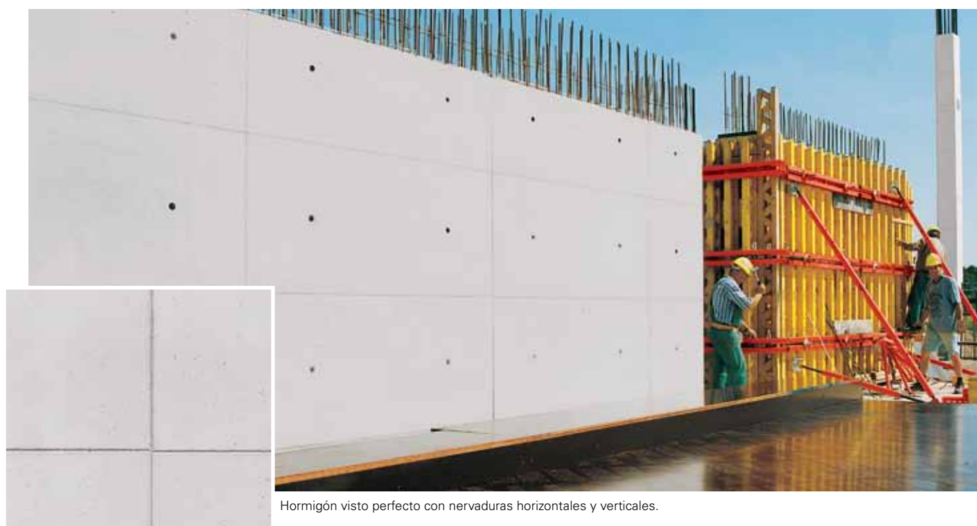
Sala de velatorios en Neubiberg. VARIO con una trama ordenada de los puntos de atado. Tablero atornillado desde atrás.
