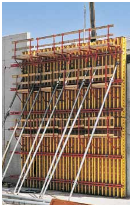
Módulos VARIO GT 24 unidos en altura para un edificio administrativo.
