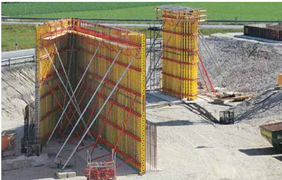
Estribo y pila con VARIO GT 24. Construcción de un cruce para la línea del tren urbano al nuevo aeropuerto de Múnich.
