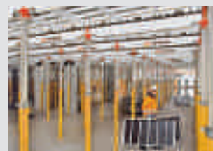
Encofrados para losas
