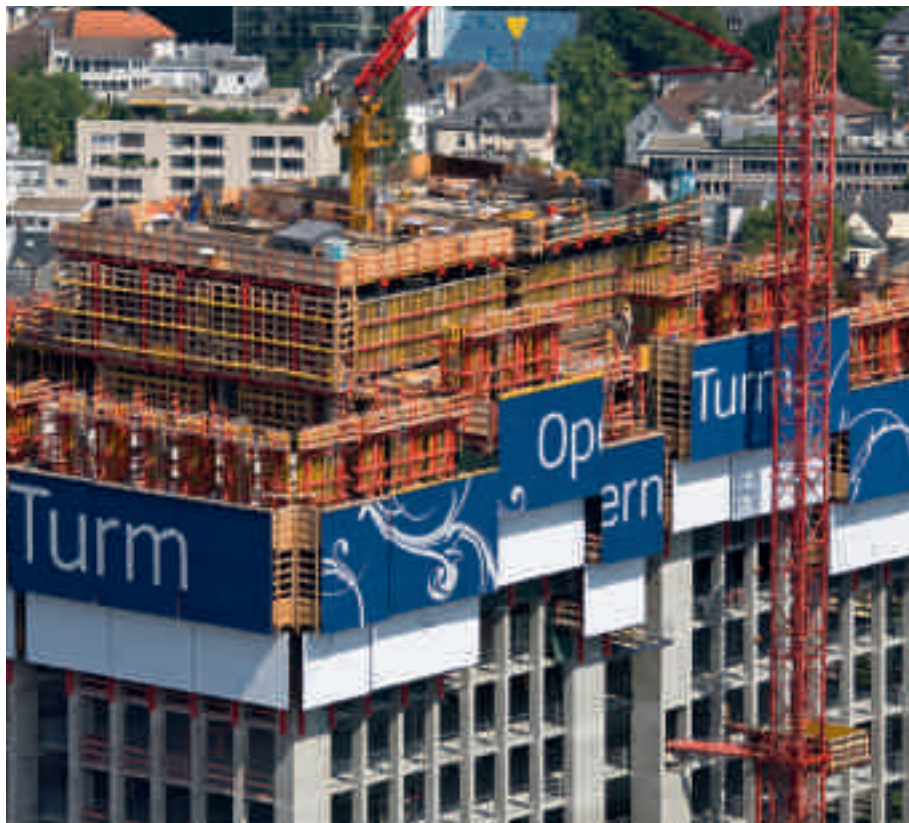
RCS ofrece lugares de trabajo seguros a máxima altura - aquí con un cerramiento completo.
