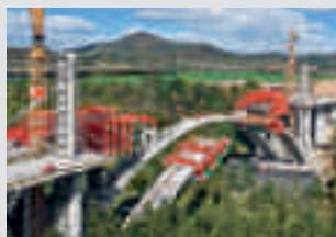
Encofrados para puentes
