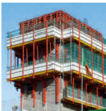
Con el sistema trepante sobre rieles RCS pueden usarse diferentes sistemas de encofrados para muros, así también el probado sistema modular TRIO.
