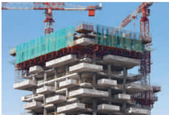
La Torre Evolución se eleva al cielo de Moscú con un elegante giro de 150 grados hasta casi 250 m de altura. Unidades de panel protector trepante RCS inclinadas, independientes de la grúa, brindan gran seguridad.
