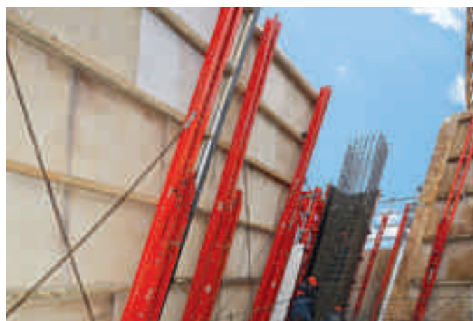
Los rieles trepantes del panel protector RCS siguen aquí el recorrido inclinado de la construcción. Soportes especiales para losa permiten una conexión segura de los rieles y la construcción.
