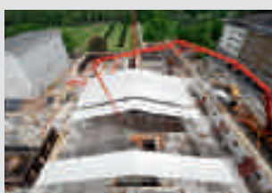
Andamios de protección
