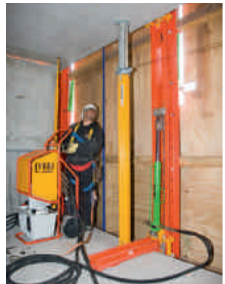
Las unidades de trepado se elevan con una velocidad de 1 m/min. hacia arriba.
