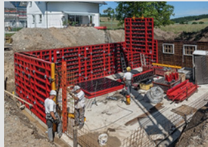
Encofrados para muros
