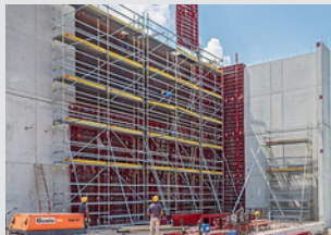
Andamios de trabajo para la construcción
