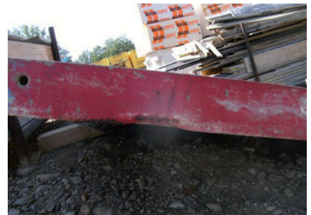
Daños en el perfil final debido a un uso incorrecto del gancho de elevación
