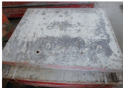
Giro ■ Placa sustituida
