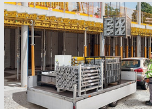
Componentes y accesorios para la obra
