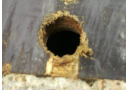
Agujero en donde pasa la barra está dañado
