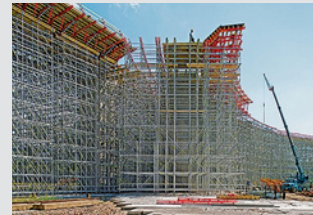
Cimbras y torres de carga
