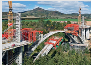
Encofrados para puentes
