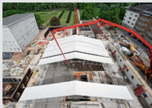
Andamios de protección
