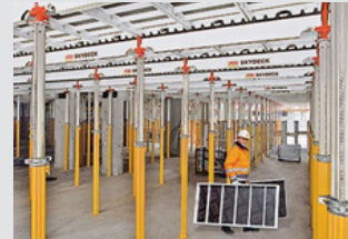
Encofrados para losas
