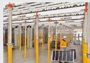
Encofrados para losas
