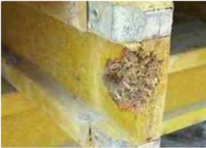
Astillado en el alma de la viga • > 20 mm
