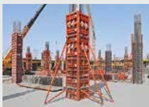
Encofrados para pilares y columnas circulares
