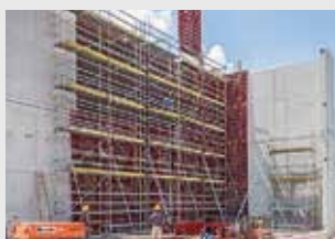
Andamios de trabajo para la construcción
