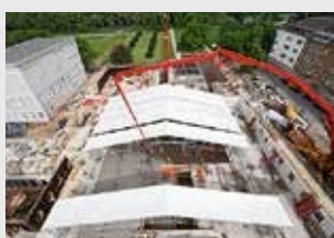
Andamios de protección
