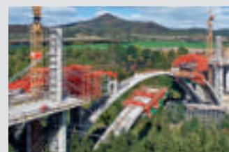
Encofrados para puentes
