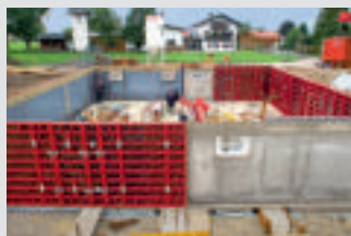
Encofrados para muros
