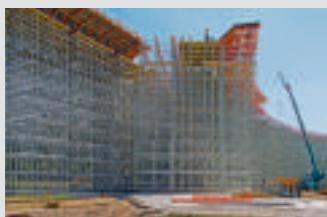
Cimbras y torres de carga
