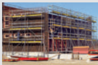
Andamios de trabajo para la construcción
