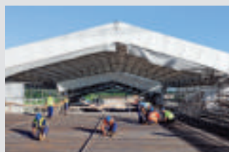
Andamios de protección
