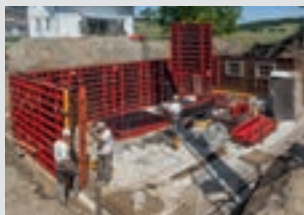
Encofrados para muros
