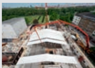
Andamios de protección
