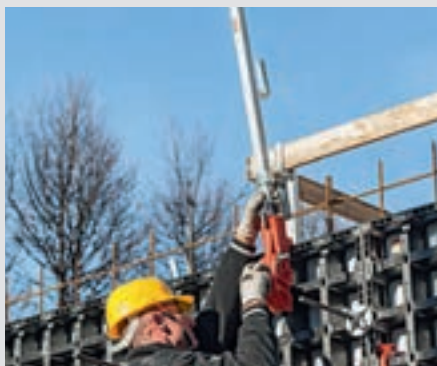
El conector de estabilizador DUO combinado con el soporte de poste de barrandilla DUO y el poste de barrandilla PERI se monta como contrabarrandilla.
