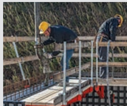
La plataforma de trabajo de 70 cm de ancho y la contrabarrandilla ofrecen condiciones óptimas para hormigonar de modo seguro.
