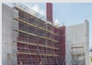
Andamios de trabajo para la construcción
