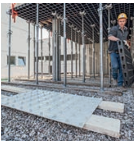
3. Preparar el nuevo tablero
