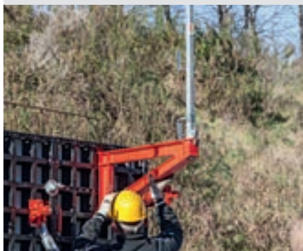
La consola DUO 70 se cuelga en las cavidades del panel. Los postes de barrandilla PERI se afirman a esa consola sin más fijación.
