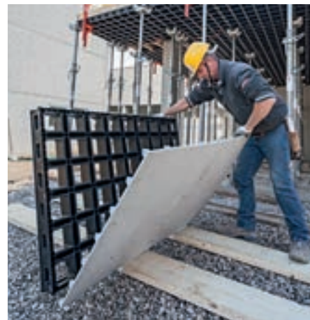
2. Retirar el tablero de encofrado dañado
