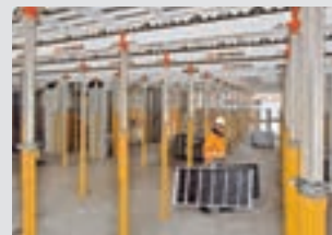
Encofrados para losas
