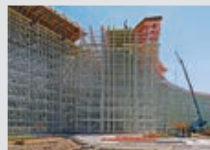
Cimbras y torres de carga
