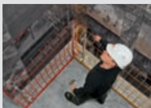
Sistemas de seguridad
