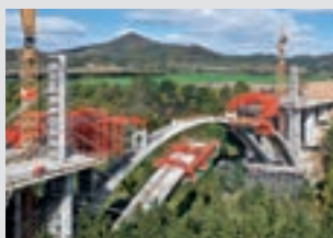
Encofrados para puentes
