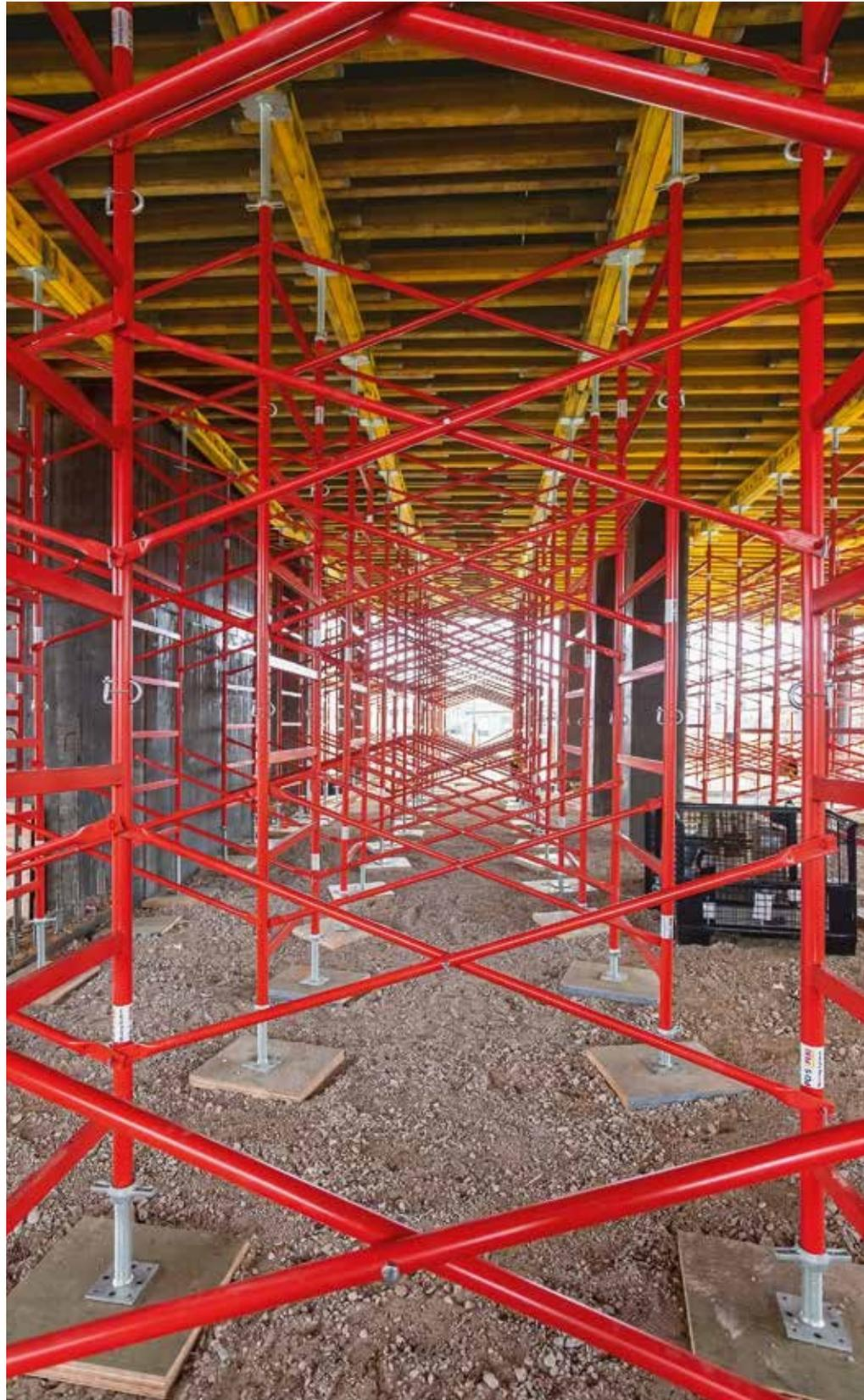
Sistema de cimbra de marcos compuestos de elementos tubulares de acero soldados y recubierto con pintura eletroestática con husillos en el cabezal y la base
