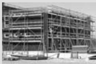
Andamios de trabajo para la construcción
