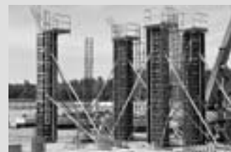
Encofrados para pilares y columnas circulares
