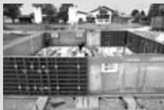
Encofrados para muros
