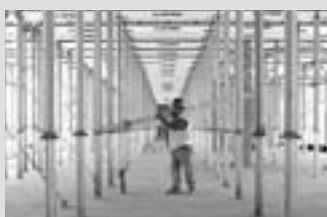
Encofrados para losas
