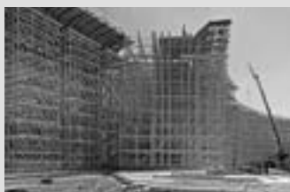
Cimbras y torres de carga
