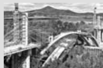
Encofrados para puentes
