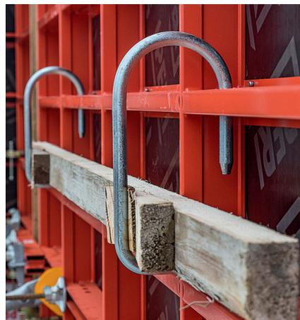
La pieza auxiliar de carga también puede usarse para posicionar los paneles LIWA alineados: simplemente se cuelga de los orificios de conexión en el panel y se coloca una madera escuadrada.
