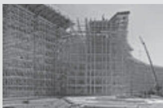
Cimbras y torres de carga
