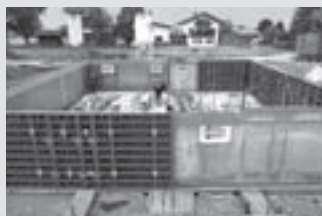
Encofrados para muros
