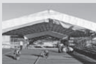
Andamios de protección
