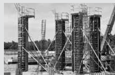
Encofrados para pilares y columnas circulares
