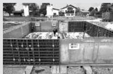
Encofrados para muros
