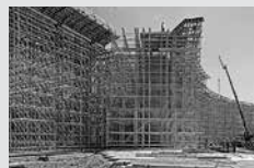
Cimbras y torres de carga
