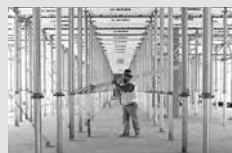
Encofrados para losas
