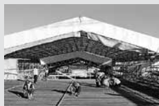
Andamios de protección
