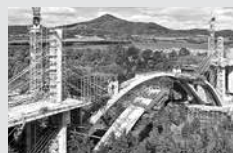
Encofrados para puentes
