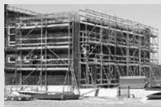
Andamios de trabajo para la construcción
